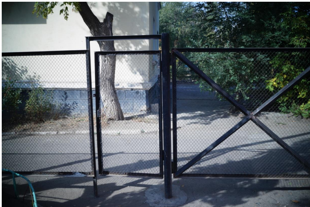
Фото 1-2 Территория прилегающая к зданию
